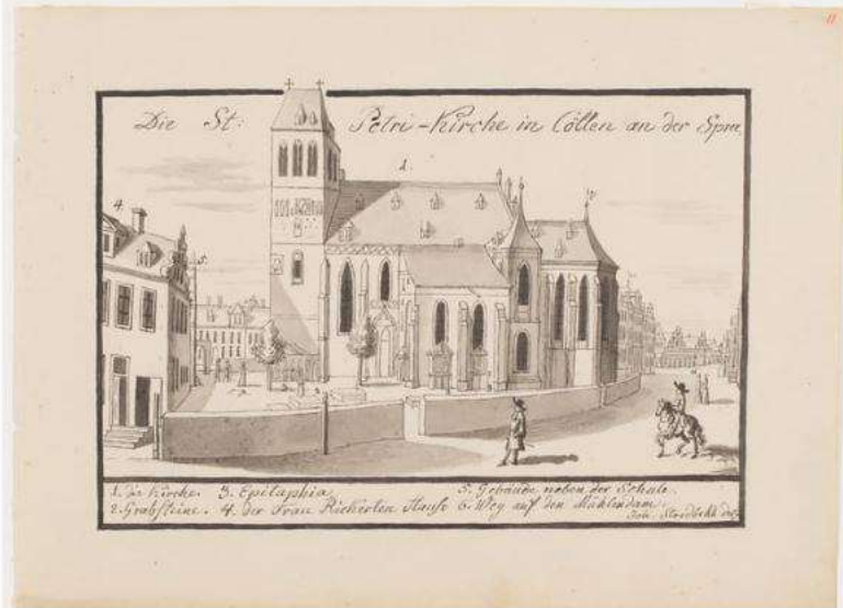
Fig. 4 SpGo_1690_Südfassade Abb_2_GHZ 64-3,11.jpg
