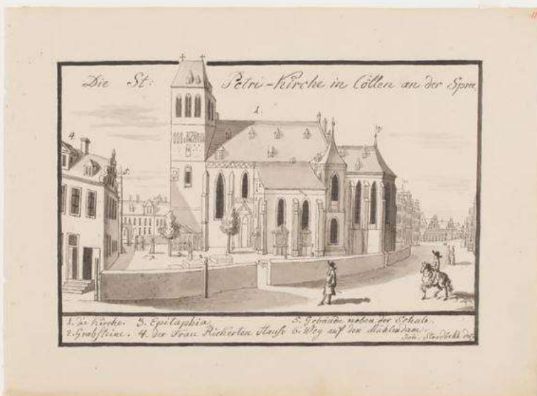
Fig. 4 SpGo_1690_Südfassade Abb_2_GHZ 64-3,11.jpg
