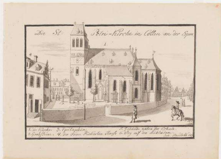
Fig. 4 SpGo_1690_Südfassade Abb_2_GHZ 64-3,11.jpg
